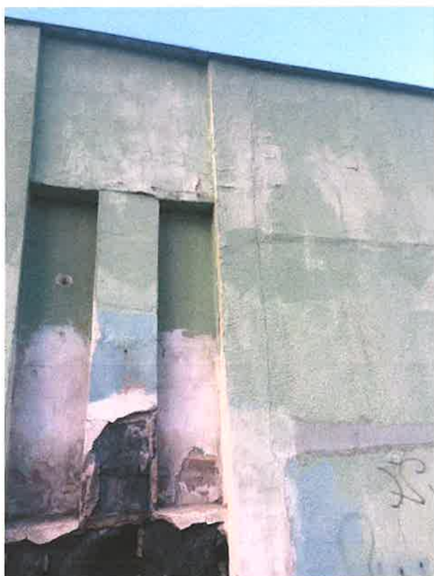
Obr.č.14 pohled na degradované sloupky plynosilikátu od kom.Šrémkova,
