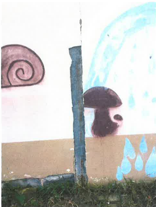
Obr.č.21 pohled na zkorodované ocelové prvky držící stěnové panely od parkoviště
