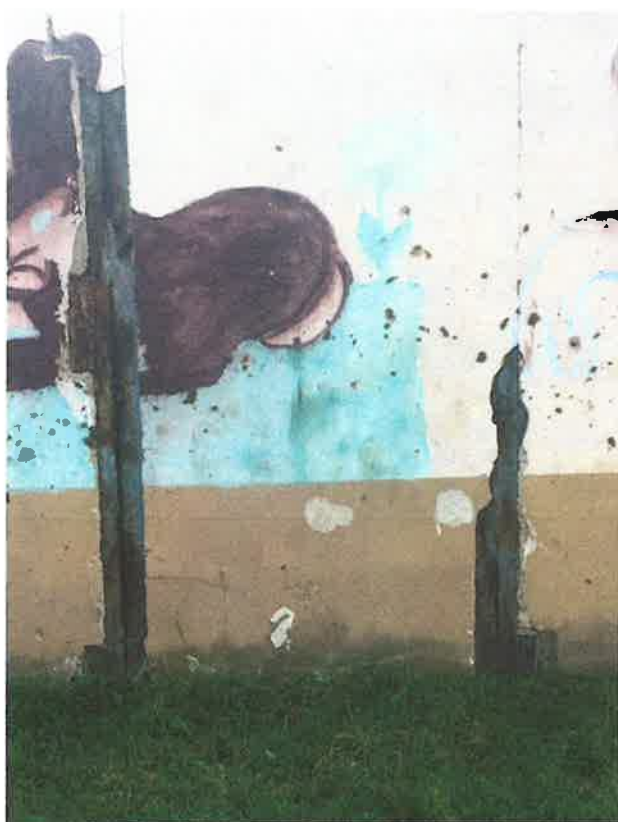
Obr.č.19 pohled na zkorodované ocelové prvky držící stěnové panely od parkoviště
