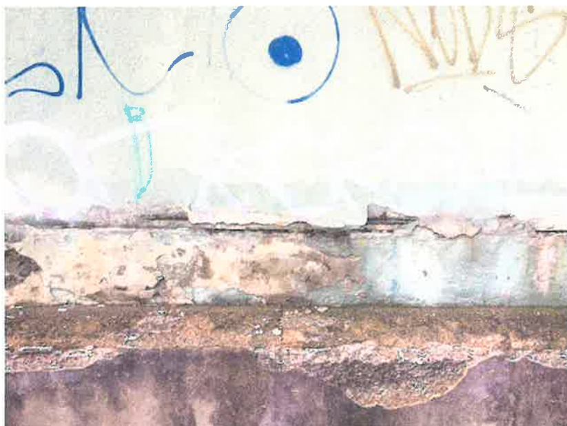
Obr.č.13 pohled na degradovaný beton základu
