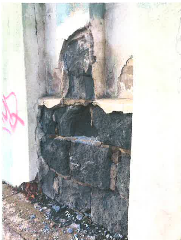
Obr.č.11 pohled na degradované sloupky plynosilikátu od kom.Šrémkova, korodující připojení OK a degradovaný beton základu
