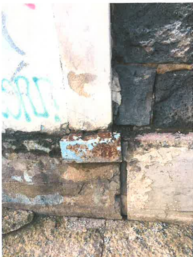
Obr.č.15 pohled na degradované sloupky plynosilikátu od kom.Šrémkova, korodující připojení OK a degradovaný beton základu
