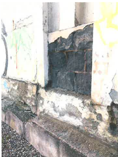
Obr.č.9 pohled na degradované sloupky plynosilikátu od kom.Šrémkova, korodující připojení OK a degradovaný beton základu
