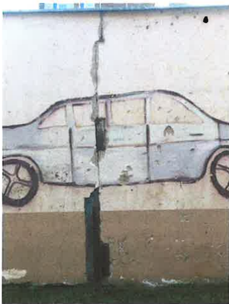
Obr.č.20 pohled na zkorodované ocelové prvky držící stěnové panely od parkoviště
