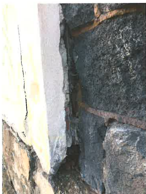
Obr.č.16 pohled na degradované sloupky plynosilikátu od kom.Šrémkova,
