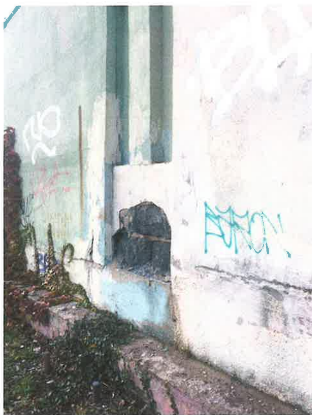
Obr.č.18 pohled na degradované sloupky plynosilikátu od kom.Šrémkova,
