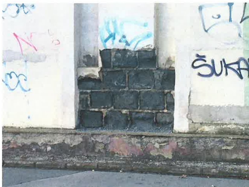
Obr.č.12 pohled na degradované sloupky plynosilikátu od kom.Šrémkova, korodující připojení OK a degradovaný beton základu
