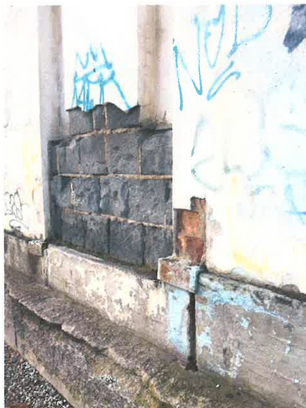
Obr.č.6 pohled na degradované sloupky plynosilikátu od kom.Šrémkova, korodující připojení OK a degradovaný beton základu
