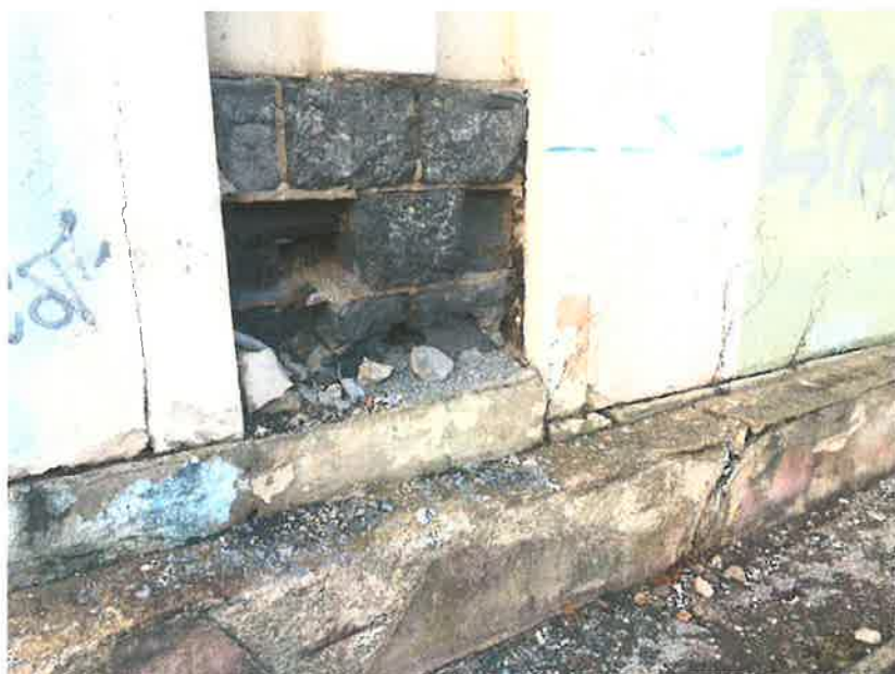
Obr.č.17 pohled na degradované sloupky plynosilikátu od kom.Šrémkova,
