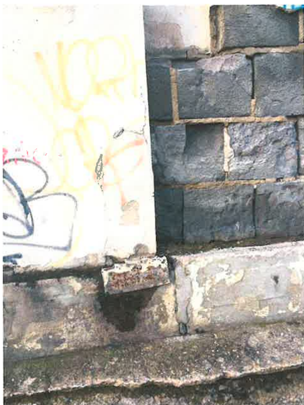
Obr.č.7 pohled na degradované sloupky plynosilikátu od kom.Šrémkova, korodující připojení OK a degradovaný beton základu
