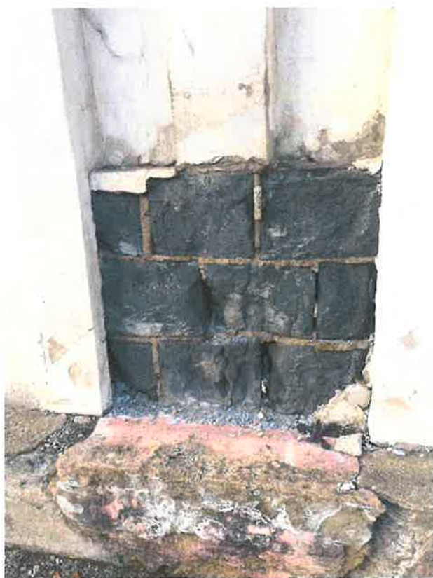
Obr.č.10 pohled na degradované sloupky plynosilikátu od kom.Šrémkova, korodující připojení OK a degradovaný beton základu
