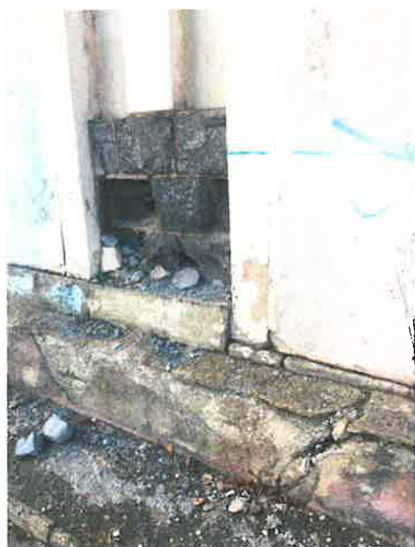
Obr.č.8 pohled na degradované sloupky plynosilikátu od kom.Šrémkova, korodující připojení OK a degradovaný beton základu
